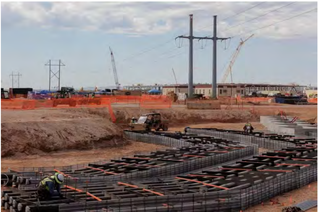
Un centre de données OpenAI en construction à Abilene, au Texas, le 23 septembre 2025. SHELBY TAUBER/REUTERS
